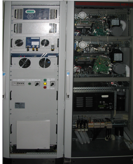
Rys. 5. System zasilania z ogniwami paliwowymi wytwarzający energię z paliwa metanolowego [3]
