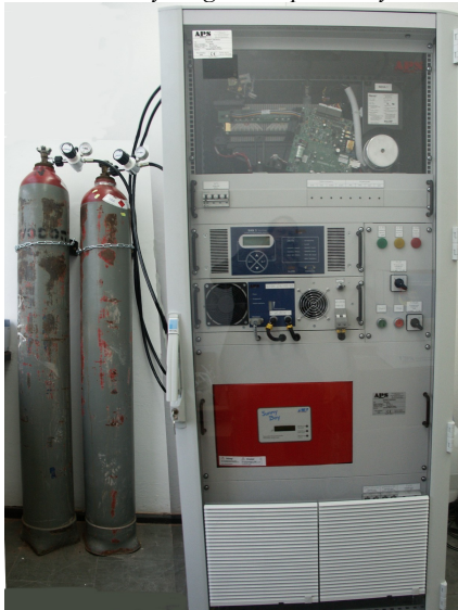
Rys. 3. Wyspowy system zasilania z wodorowym ogniwem paliwowym
