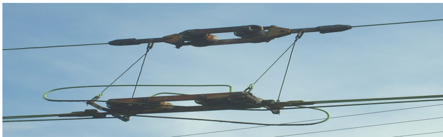
Fot. 1. Kompletny izolator sekcyjny stosowany w okresie intensywnej elektryfikacji PKP
