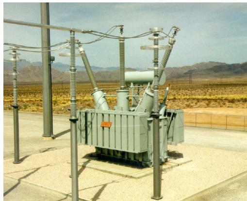
Rys. 4. Dławik trójfazowy do kompensacji mocy biernej w linii 400 kV (160 MVar) [1]
