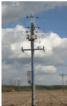
Rys.3. Przykładowe rozwiązanie punktu rozłącznikowego sterowanego zdalnie z wykorzystaniem rozłącznika NXBD. Instalacja na terenie Koncernu Energetycznego ENEA SA.
