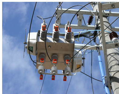
Rys.3. Przykładowe rozwiązanie punktu rozłącznikowego sterowanego zdalnie z wykorzystaniem rozłącznika NXBD. Instalacja na terenie Koncernu Energetycznego ENEA SA.
