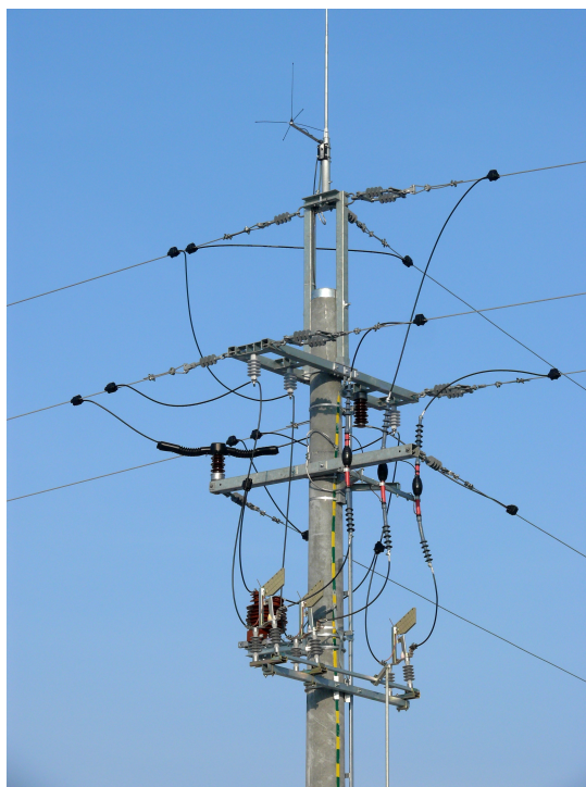
Rys. 1. Stanowisko rozłącznika aktywnego A-SRN-24 w ZE Białystok Teren
