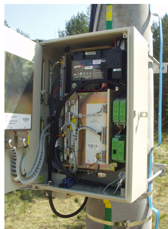
Samoczynny napowietrzny wyłącznik próżniowy KTR: a) budowa, b) widok ogólny, c) zabudowa na stanowisku słupowym, d) szafa sterownicza
