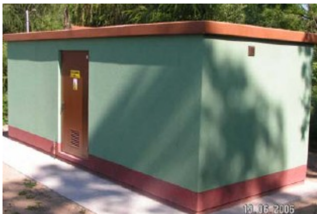
Rys. 3. Stacja po zakończeniu budowy: a) rozdzielnica z SF 6 , b) szafa telemechaniki, c) widok zewnętrzny
