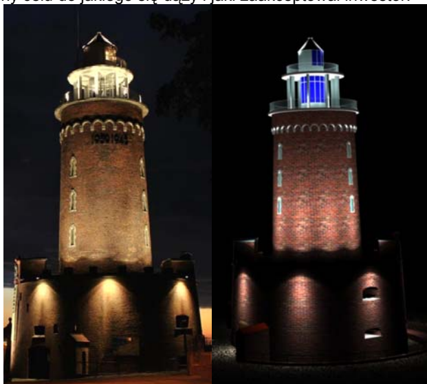
Rys.14. Zdjęcie i wizualizacja oświetlenia fortu i latarni morskiej
