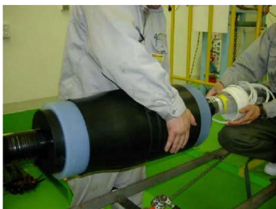
Rys. 5. Montaż mufy 400 kV [12]
