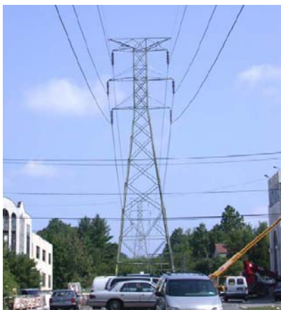
Rys. 1. Wysokonapięciowa linia napowietrzna w centrum osiedla mieszkaniowego [7]
