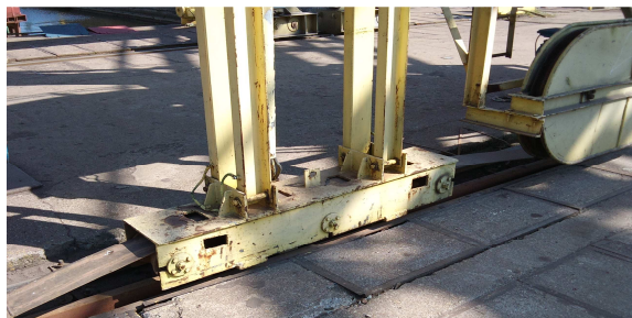
Rys. 1. Widok kanału trolejowego z powierzchni ziemi [4]
