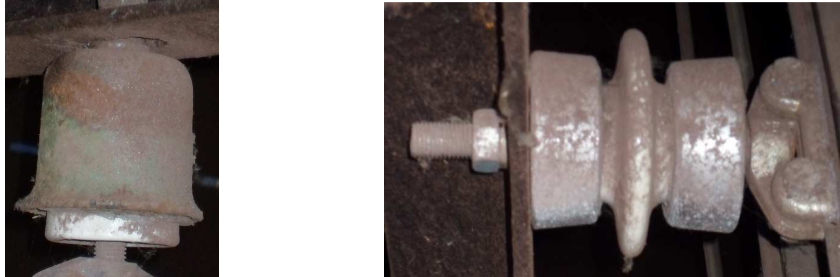
a) b) Rys 3. Izolator uchwytny typu TiU-25 pracujący w pozycji pionowej (a) i izolator uchwytny typu Tn Um pracujący w pozycji poziomej (b) [4]
