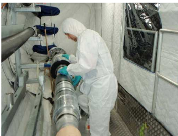
Rys. 3. Montaż muf kablowych wewnątrz namiotu [4]
