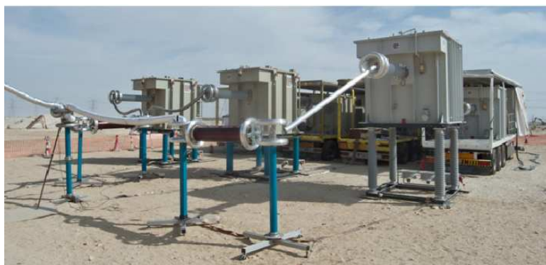
Rys. 7. Badanie linii kablowej 400 kV w Katarze [10]
