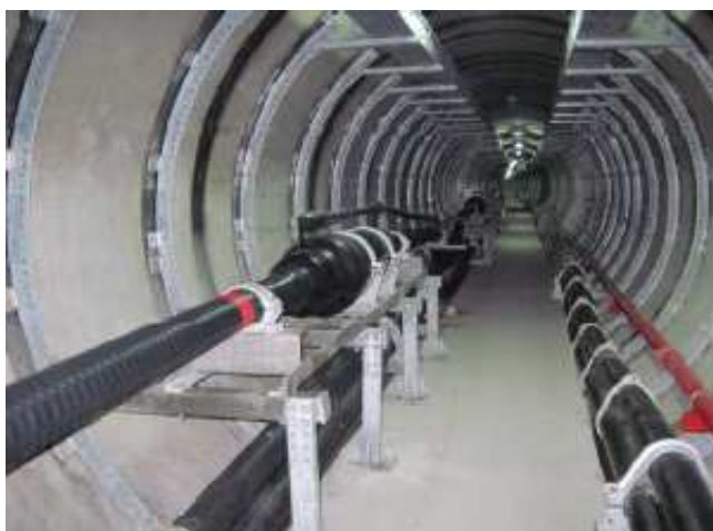
Rys. 5. Ułożenie linii kablowej 500 kV w tunelu – Szanghaj [5]
