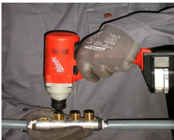
Rys. 10: Montaż złączki mechanicznej ze śrubami zrywalnymi
