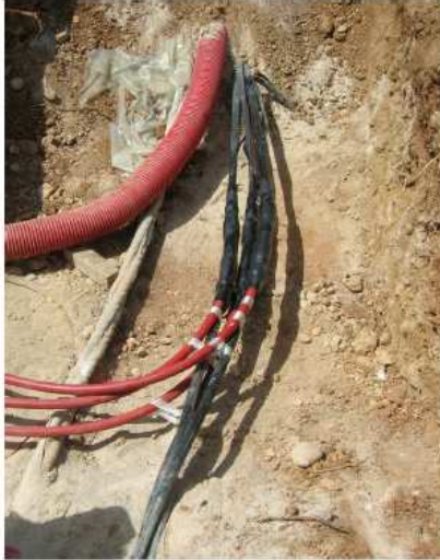
Rys. 2. Mufa kablowa rozgałęźna o napięciu pracy 24kV
