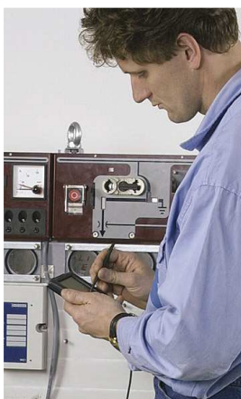
Rys.4 Nastawianie zabezpieczenia
