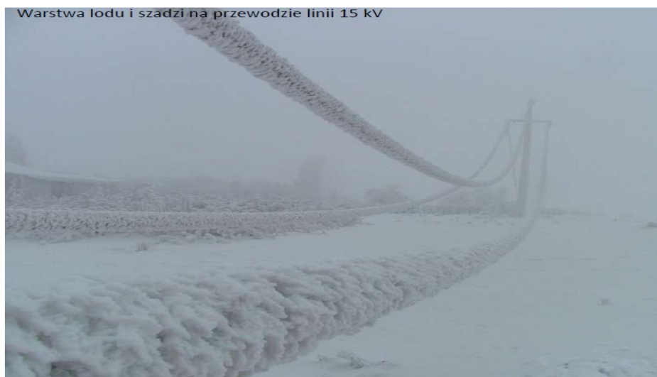
Rys. 2. Przykład nadmiernego oblodzenia.
