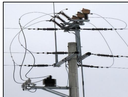
Rys. 3. Widok rozłącznika z małoolejowymi komorami gaszeniowymi z telesterowaniem. Źródło: [5].
