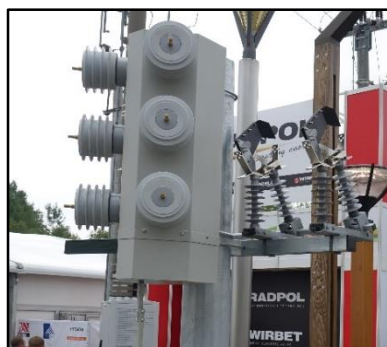
Rys. 10. Widok rozłącznika o obudowie zamkniętej z próżniowymi komorami gaszeniowymi. Źródło: materiały autora.
