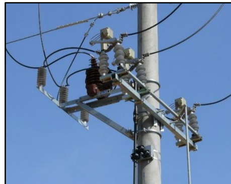
Rys. 5. Widok rozłącznika z próżniowymi komorami gaszeniowymi z telesterowaniem. Źródło: [5].
