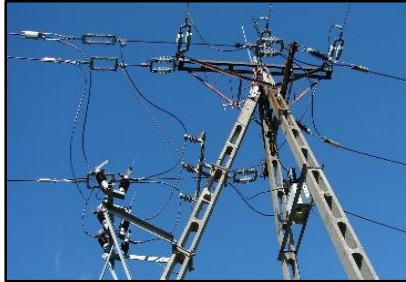
Rys. 1. Widok rozłącznika z opalnym stykiem migowym z telesterowaniem. Źródło: [5].
