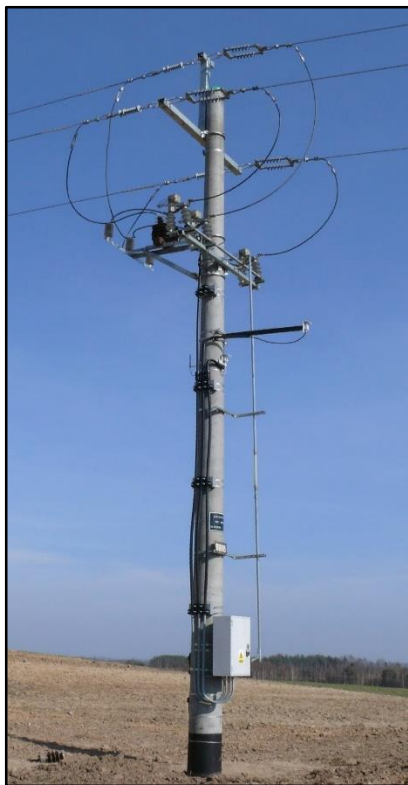
Rys. 4. Widok rozłącznika z próżniowymi komorami gaszeniowymi z telesterowaniem wraz z napędem wyposażonym w ciągną. Źródło: [26].
