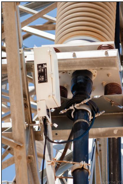
Fot. 5. Optyczny czujnik prądowy na słupie WN.
