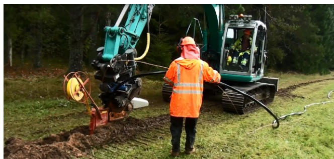
Rys. 1. Metoda płużenia pługiem wibracyjnym.
