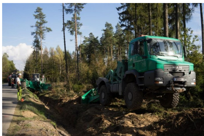
Rys.2. Metoda płużenia pługiem ciągnionym.
