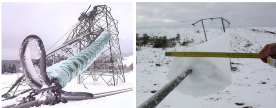
Rys.1. Słowenia 2014 – zniszczona linia 400 kV oraz Islandia 2012 – osad lodowy o wymiarach 20x30 cm [2]
